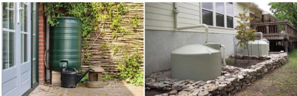
Joonis 6-2 Näiteid vihmavee kogumise lahendustest (vasakul 24 lahendus väheste kastmisvee vajaduse katmiseks ja paremal 25 lahendus suurema kastmisvee vajaduse katmiseks).
